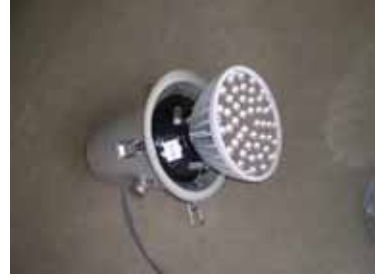
灯具にLED取付完了
