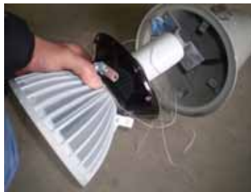
LEDに口金を取付ける。 柱)口金の+と-を間違わないように
