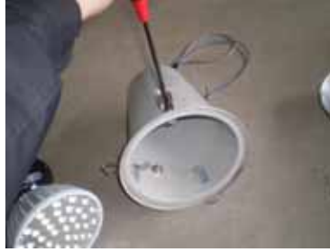
反射板取付金具を上下反転取付する
