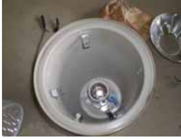
灯具内の口金及びフレンジを取外す
