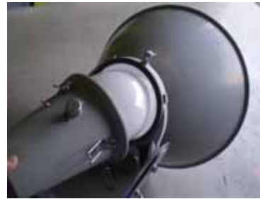
金具の先端を切断加工し、ビス仮止め
