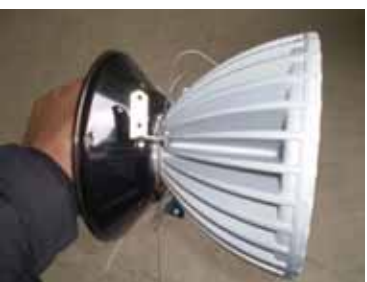
取付金具2にLEDを合わせて位置、スミ出し、穴あけ
