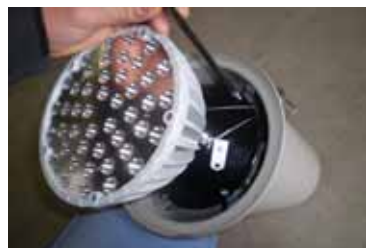
反射板取付金具に取付金具を取付ける
